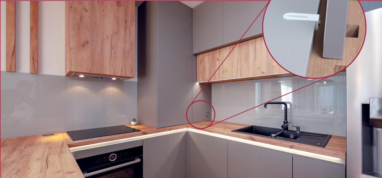
Grifflose Küchentüren mit Push-to-open Türöffnern benötigen eine 2-3 mm Fuge zwischen Tür und Korpus. Mit dem leicht hervorstehenden Cabineo kann die Blindfront in einem Arbeitsgang bereits fluchtend mit der Sichtfront festgeschraubt werden.
