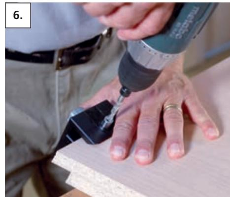
6. Clamex P Zugangsöffnung bohren
