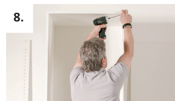
8. Möbel fertig verbinden und fixe Zwischenböden nachträglich montieren
