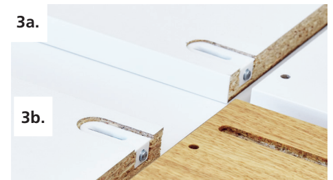
Verbinder aufsetzen und einschlagen
