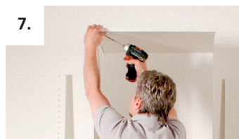
7. Akkuschrauber bereithalten und vordere Ecke verschrauben. So sind auch Einmannmontagen problemlos möglich
