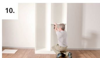
10. Tipp: - Boden einseitig auf Tablarträger legen und andere Seite befestigen - Bündig zurückgedrehte Schrauben erleichtern den Einbau
