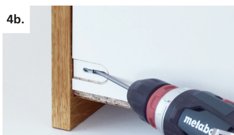
Schubladen Seiten mit Vorderstück verbinden
