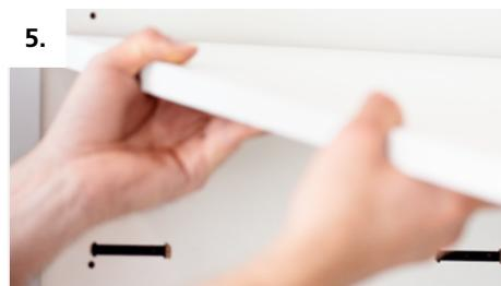
5. Fachboden von oben nach unten einfahren bis die Positionierbolzen im Gegenstück einrasten
