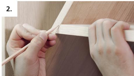
2. Bauteil an korrekter Position des Gegenstücks auflegen und Mittelriss übertragen.
