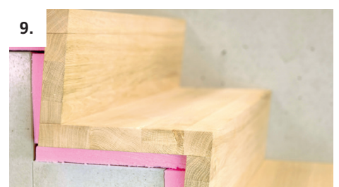
9. Fertig ist die Faltwerktreppe.
