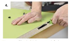
Vorspann-Clip eindrücken zum einfacheren Zusammenfügen der Bauteile.
