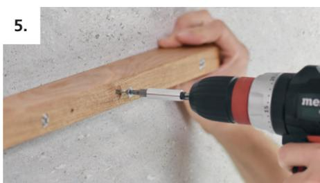
5. Montageleiste ausrichten und an der Wand befestigen
