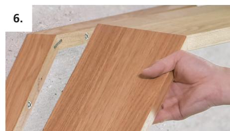
6. Montageleiste und Tablar direkt an der Wand zusammensetzen
